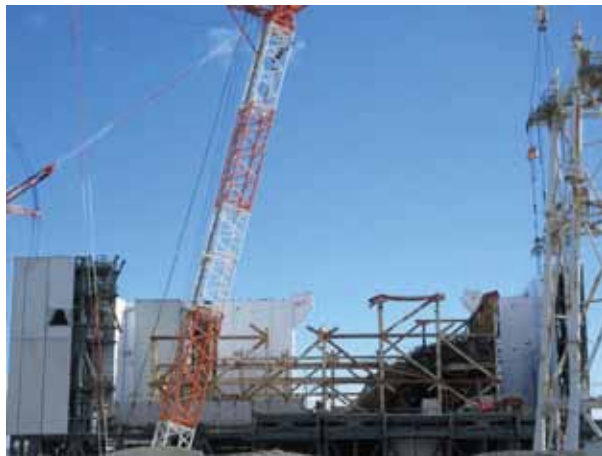
1号機の様子。建屋全体を覆う大型カバーを設置中(写真上)。目前に被災した原発を見ることができました(写真左下)。
